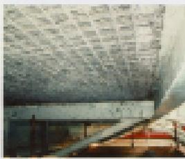
Dopo il corretto posizionamento della rete elettrosalata, l'operatore provvede all'applicazione a spazzola l'1° strato di FIBRETEX T4.
