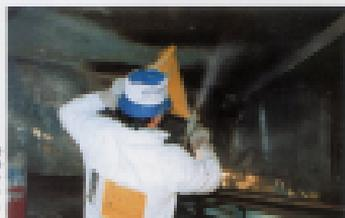
Fase applicativa relativa alle opere di impermeabilizzazione e protezione eseguita a spazzola con il cemento impermeabilizzante **VANDEK SUPER**.
